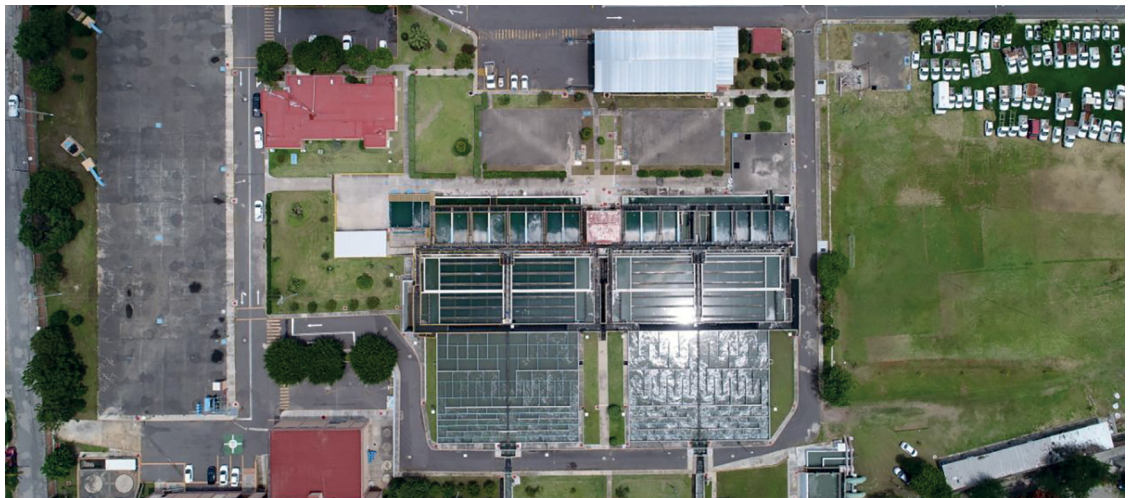
Planta Potabilizadora No. 2 "Las Huertas", SIAPA, Gobierno del Estado de Jalisco, (2022).
