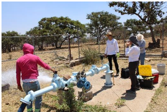
Purga del pozo
