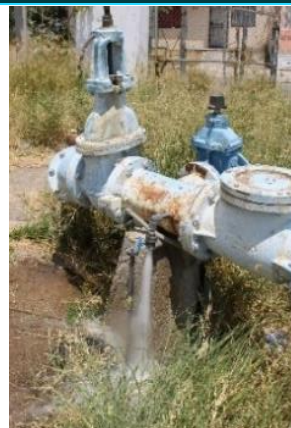
Purga del pozo
