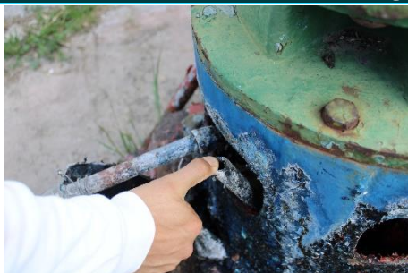
Manguera angosta para la medición del nivel
