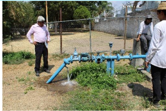
Purga del pozo
